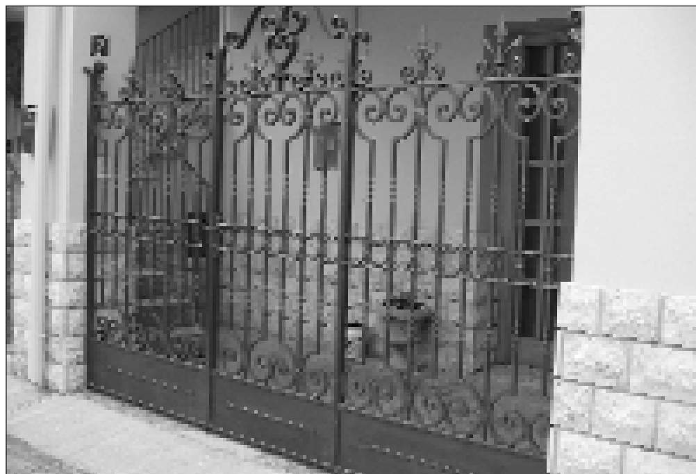
Diversos trabajos en Monreal del Campo.
